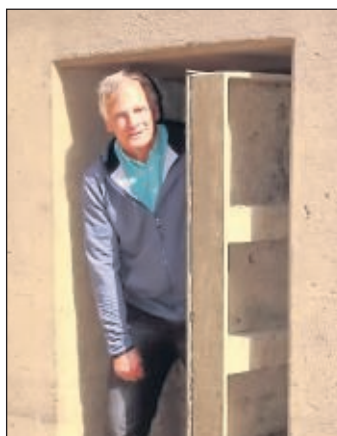
Durch eine schwere Stahltür geht es ins Schleusenbecken.
