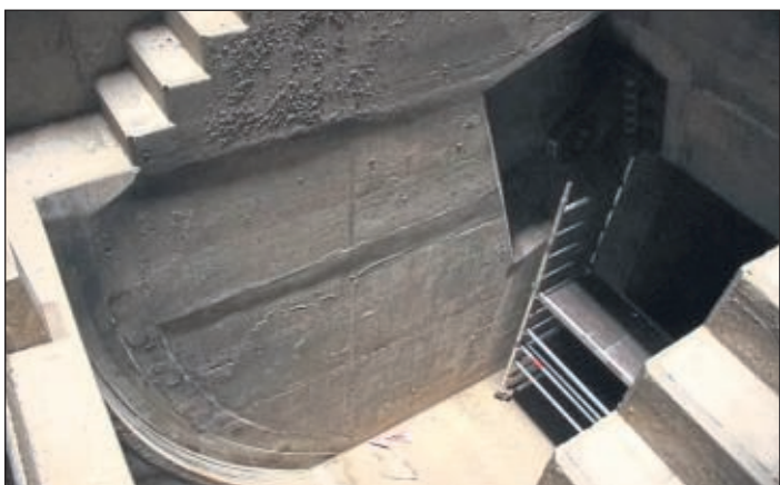
Durch Schächte wie diesen strömt das Wasser in die Schleusenammern. Unten ist einer der Drehverschlüsse ausgebaut.
