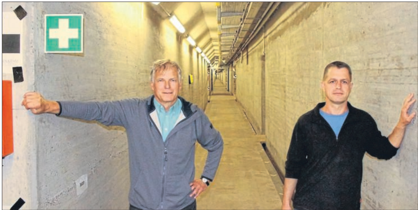
Hier kommt kein Besucher hin: Arno Liebrecht (links), stellvertretender Leiter des Wasserstraßen- und Schifffahrtsamts Uelzen, und Bezirksleiter Michael Pape im langen Betriebsgang der Esterholzer Schleuse von 2006. Fotos: Sternitzke
