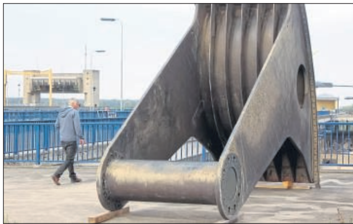
Ein ausgebauter Drehverschluss liegt auf dem Schleusengelände. In die Lager ist Wasser eingedrungen.
