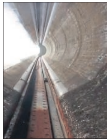
Rost und Riefen in der Führung der Schwimmpoller.
