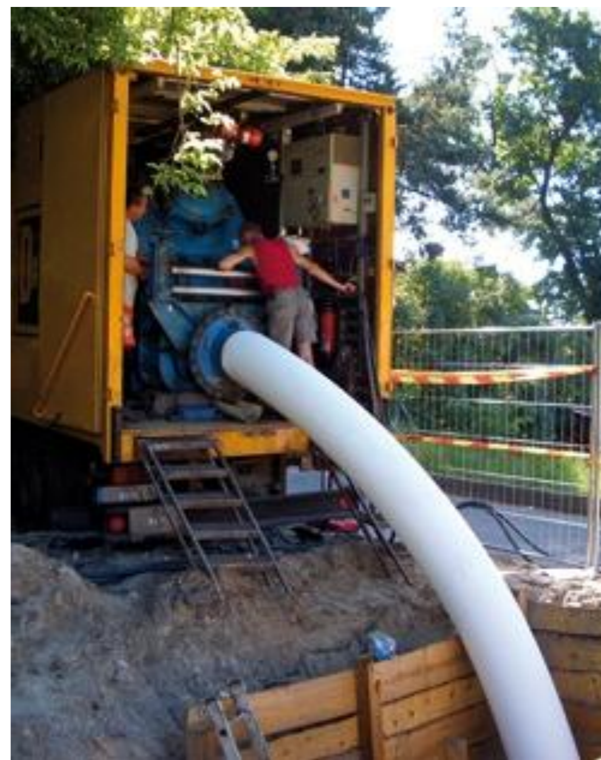
Abb: Einbau des Trinkwasserdruckliners RS BlueLine (Quelle: bi UmweltBau)
